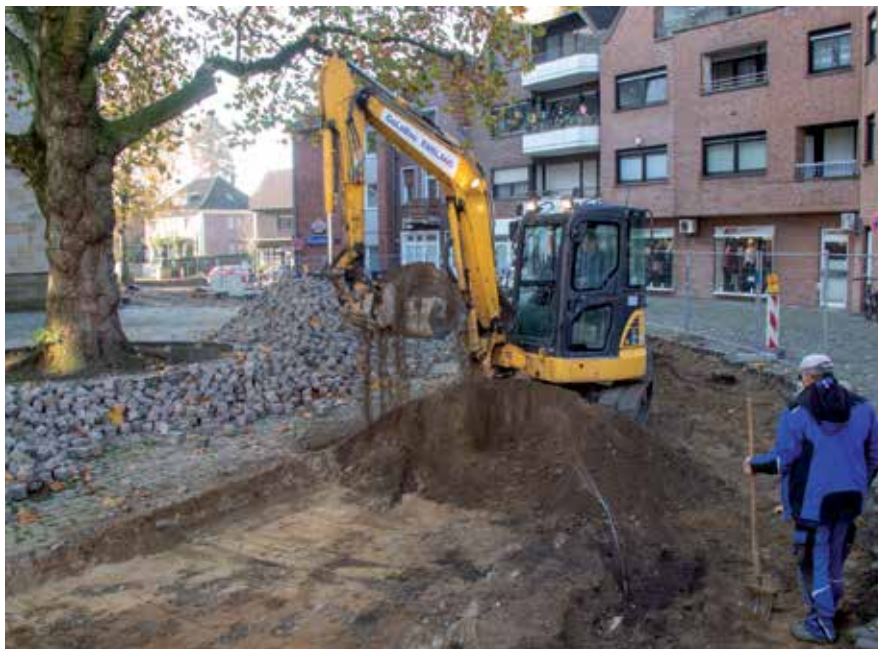
Die Bauarbeiten am Kirchring und rund um die St. Anna Kirche haben vor einigen Wochen begonnen.
