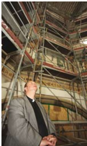
Pastor Langenfeld begutachtet die Arbeiten in der St. Anna-Kirche.
